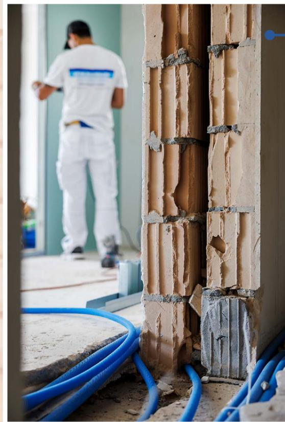
Für das Aufhängen der Badezimmertüre wird zuerst eine imprägnierte Gipsplatte mit Schnell- und Trockenschrauben montiert. Da es sich um eine Nasszelle handelt, ist die Imprägnierung wichtig. Sie schützt den Gipskern und die Kartonummantelung der Platte vor Feuchtigkeit.
