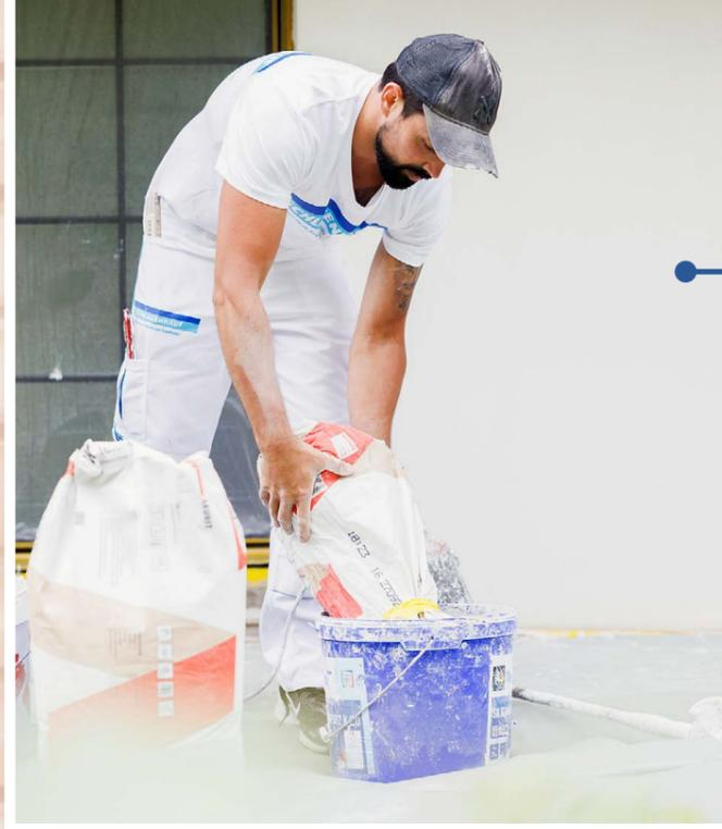
Ab nach draussen! Die Mischung für die sogenannte Netzeinbettung wird vorbereitet und dient als Basis für die neue Fassade.
