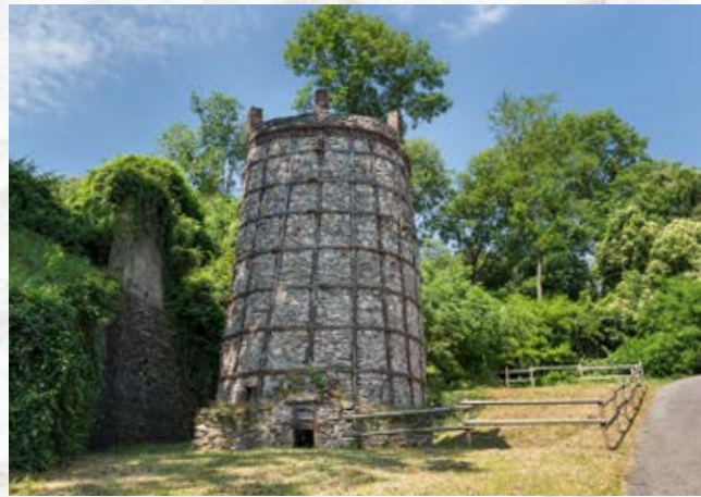
In traditionellen Öfen wurde Kalkstein bei 800 Grad Celsius gebrannt. Moderne Industrieöfen erreichen Temperaturen von bis zu 2500 Grad Celsius. Beim Brennvorgang verliert der Kalk fast die Hälfte seines Gewichts.
