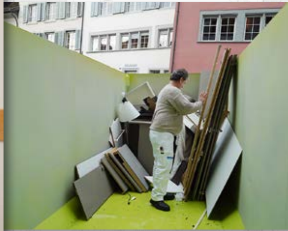
Mitarbeitende von Schlagenhauf entfernen die Möblierung und die Bodenbeläge. Was nicht mehr gebraucht wird, landet in der grossen Mulde vor dem Gebäude.
