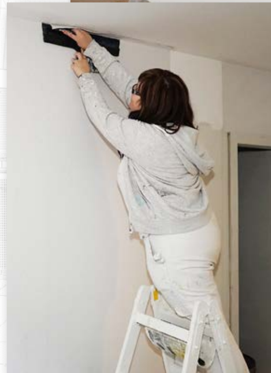
Durch die Demontage der alten Möbel sowie zahlreicher neuer Elektroinstallationen mussten diverse Wände neu tapeziert werden.
