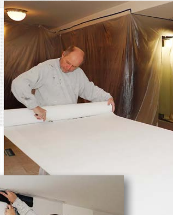
Durch die Demontage der alten Möbel sowie zahlreicher neuer Elektroinstallationen mussten diverse Wände neu tapeziert werden.
