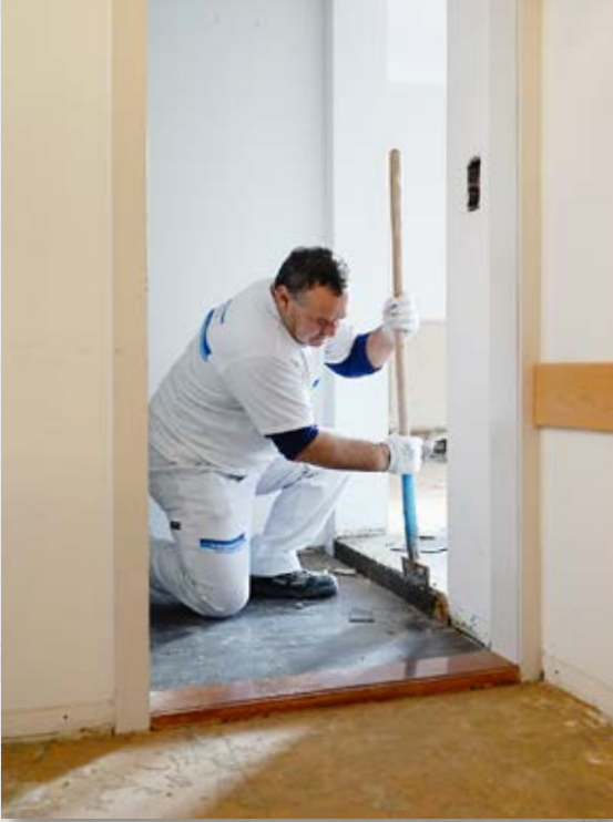
Mitarbeitende von Schlagenhauf entfernen die Möblierung und die Bodenbeläge. Was nicht mehr gebraucht wird, landet in der grossen Mulde vor dem Gebäude.
