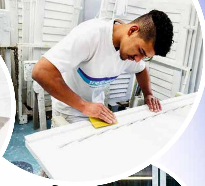
**Schleifen und Spachteln.** Für eine ebenmässige Oberfläche schleifen Mladen Andric, Oscar Alves da Silva und Santiago Secura (von links nach rechts) alte Farbanstriche an. Unebenheiten glätten sie mit Spachtelmasse.
