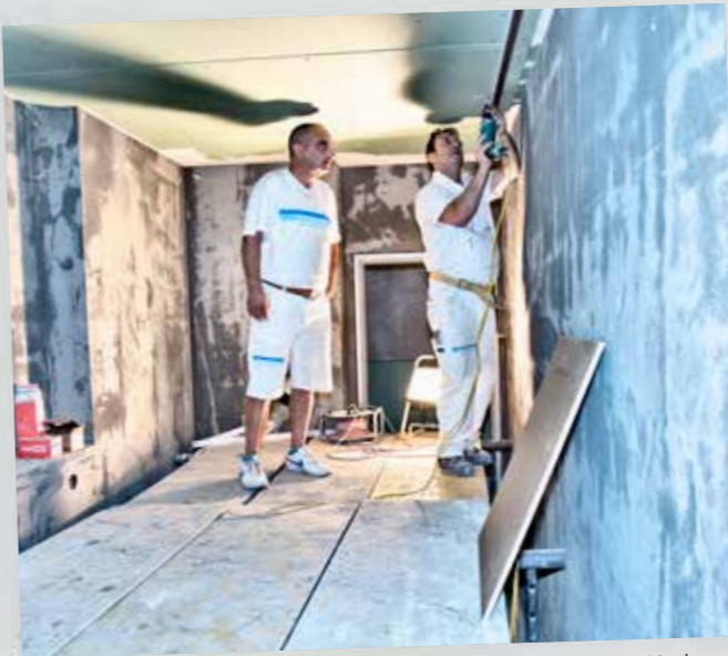
14:45 Nicht nur bei Renovationen ist der Kundenmaler tätig. In einem Neubau bespricht er mit dem Gipser von Schlagenhaut vor Ort den Status, um seine nächsten Einsätze zu koordinieren.
