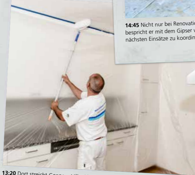
13:20 Dort streicht Gennaro Villani in einem Einfamilienhaus eine Küchendecke, die wegen eines Wasserschadens repariert werden musste.
