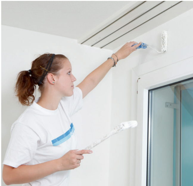
Zum Schluss wird die Fläche mit mineralischen Farbsystemen neu beschichtet.
